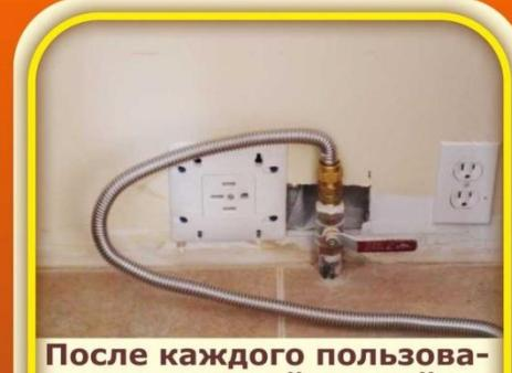
**После каждого пользования газовой плитой закрывайте краны** на плите и на вводящей трубе. Перед уходом из дома, квартиры проверить, закрыты ли доступ газа.
