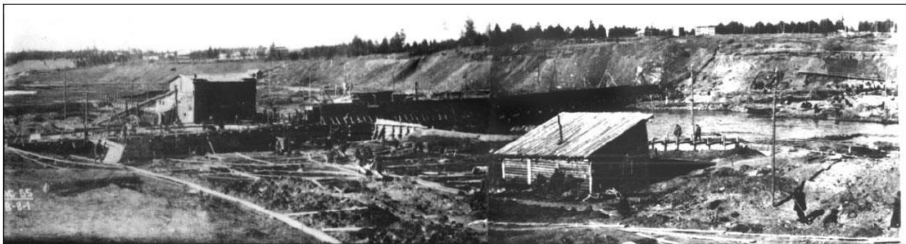
Сверху вниз: Промплощадка завода.; Строительство плотины 1942 г.
